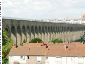
Le pont-aqueduc d'Arcueil-Cachan.
